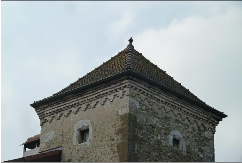
Couronnement de la tour entouré d'une frise en briques en « dents de scie » (source : UDAP 01)
