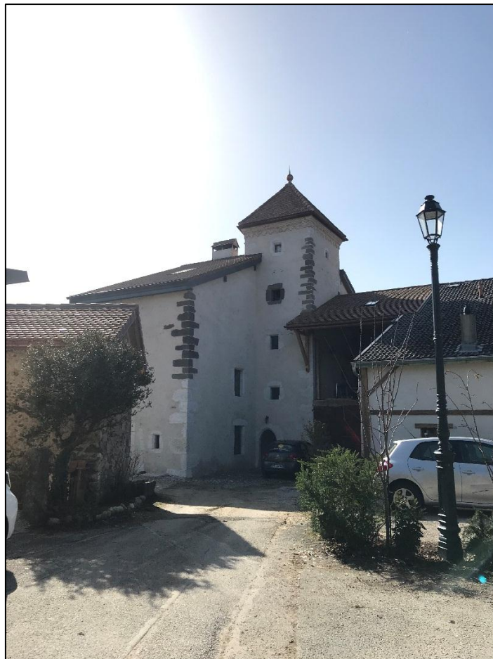
La maison haute d'Ornex, face Est après les travaux de restauration (source : UDAP 01)
