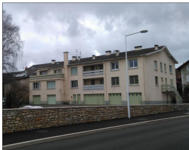
Ornex, immeuble collectif type années 1970 (source : UDAP01)
