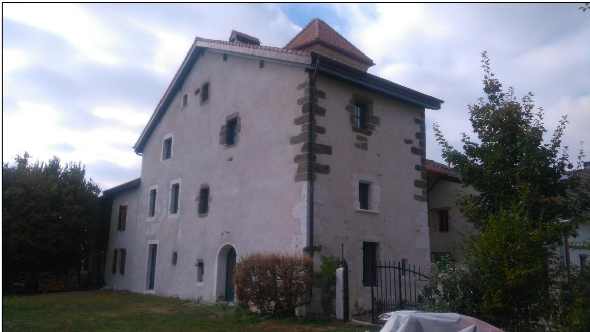
La maison haute d'Ornex, face Sud après les travaux de restauration (source : UdDAP01)
