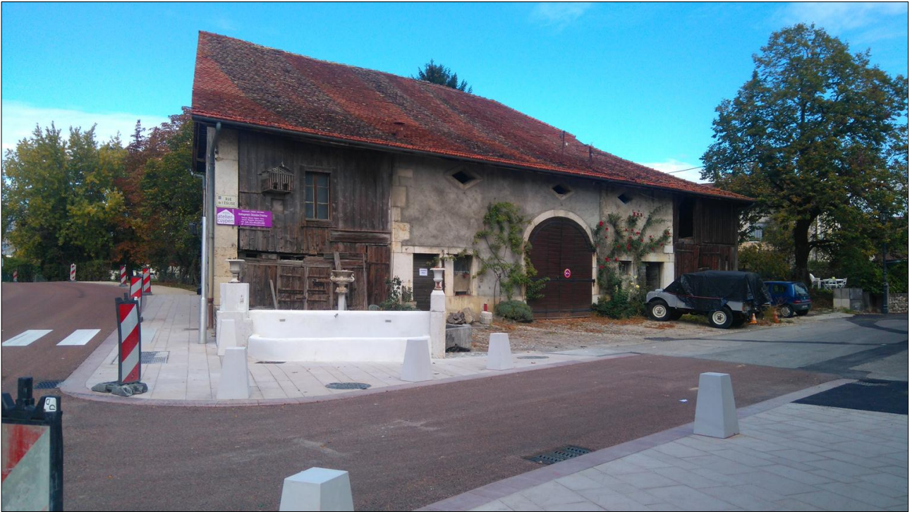
Ornex, Maison ancienne type exploitation agricole (source : UDAP01)
