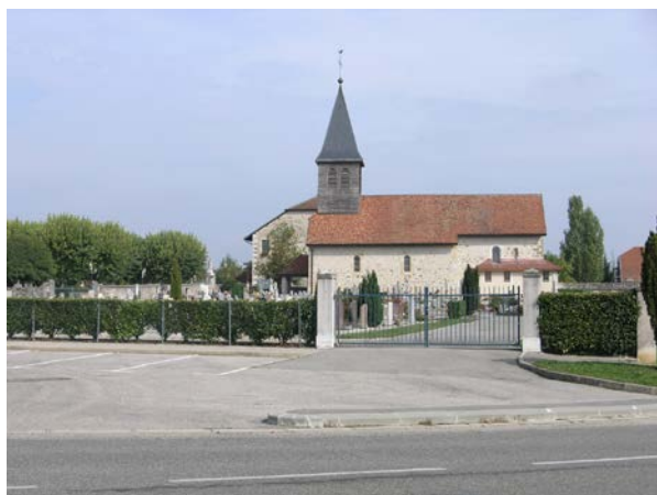
4. Le monument protégé et l'accès au cimetière
