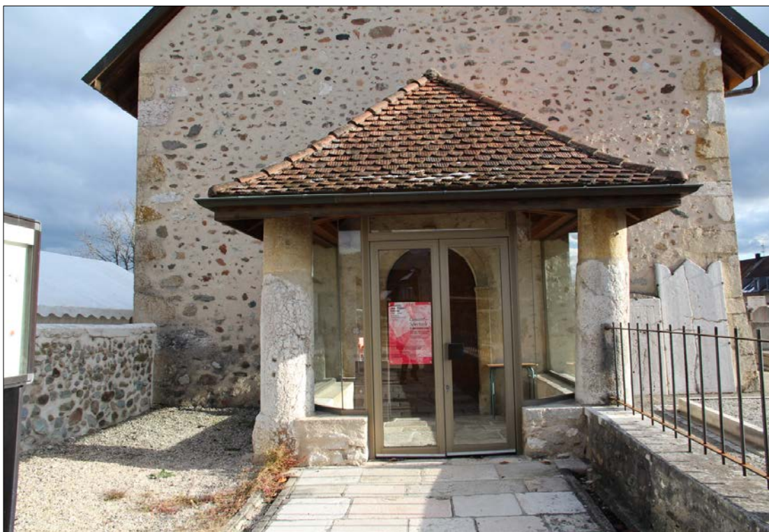
Auvent de l'église de Prevsin-Moëns (source : UDAP01)
