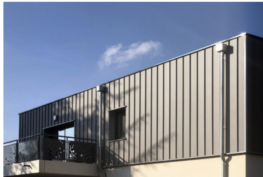
Bardage métallique aspect joint debout Logements - La Bastide du Couchant - Saint Galmier Source : Atelier 3s
