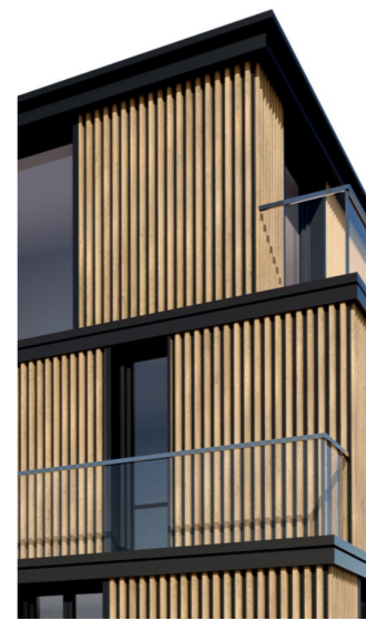
Bardage métallique aspect faux-claire-voie 3s Source : Atelier 3s
