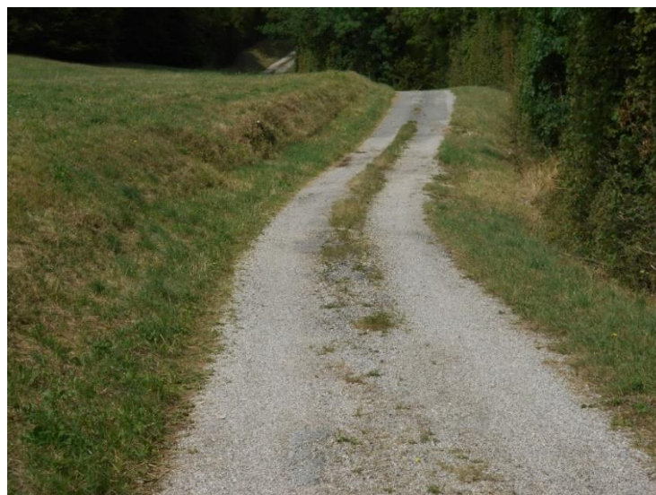
Zone de transformation de route bitumée en route empierrée
