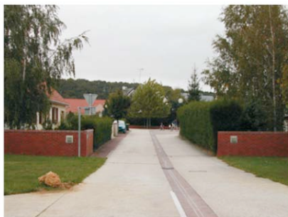
Rue de lotissement
