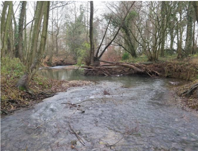
Vue en aval de l'ouvrage dans l'espace alluvial...
