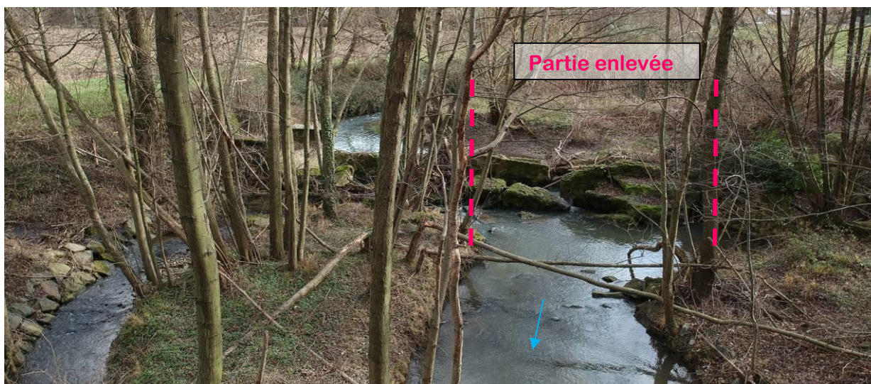
▲ Vue de l'aqueduc (---= Partie enlevée)
