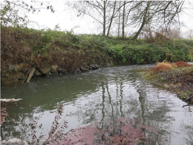
Vue de l'amont immédiat de l'ouvrage...
