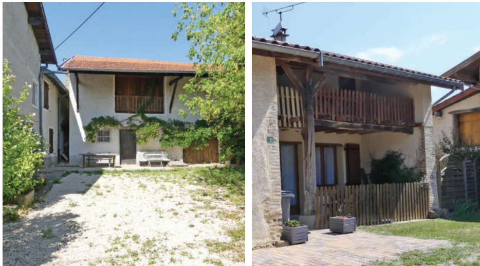
BARDAGE BOIS ET GRANDES OUVERTURES
