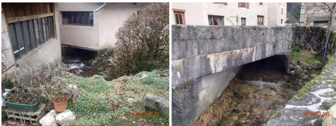
Figure 13 : Courtes ouvertures sur le tronçon couvert de la Merveille
