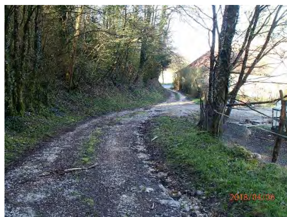
Figure 29 : Piste ravinée par l'érosion et maison susceptible d'être atteinte au second plan
