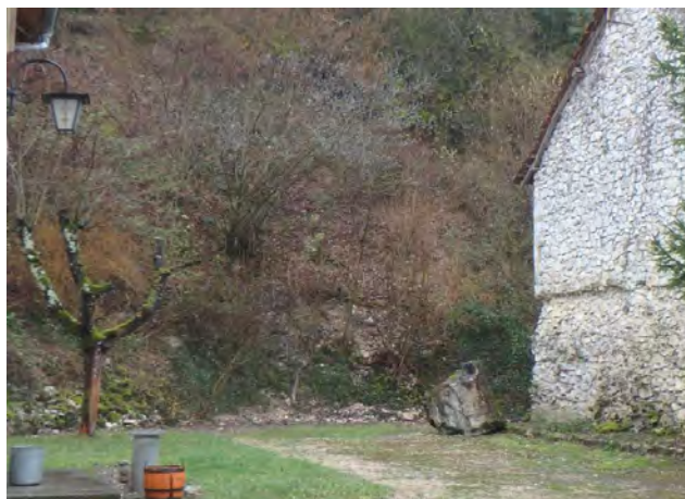
Figure 8 : bloc d'environ 2 m 3 éboulé (relativement ancien)
