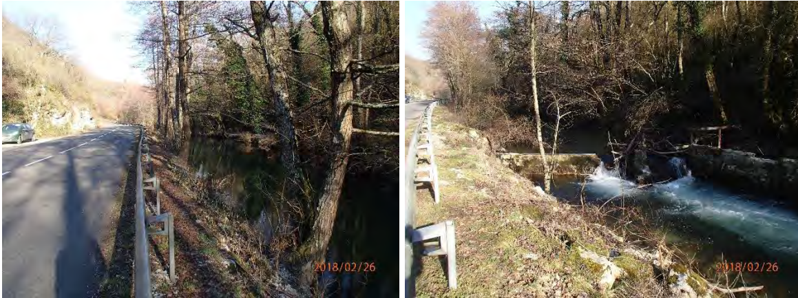
Figure 18 : Ruisseau du Gland le long de la RD10, en amont de la cascade
