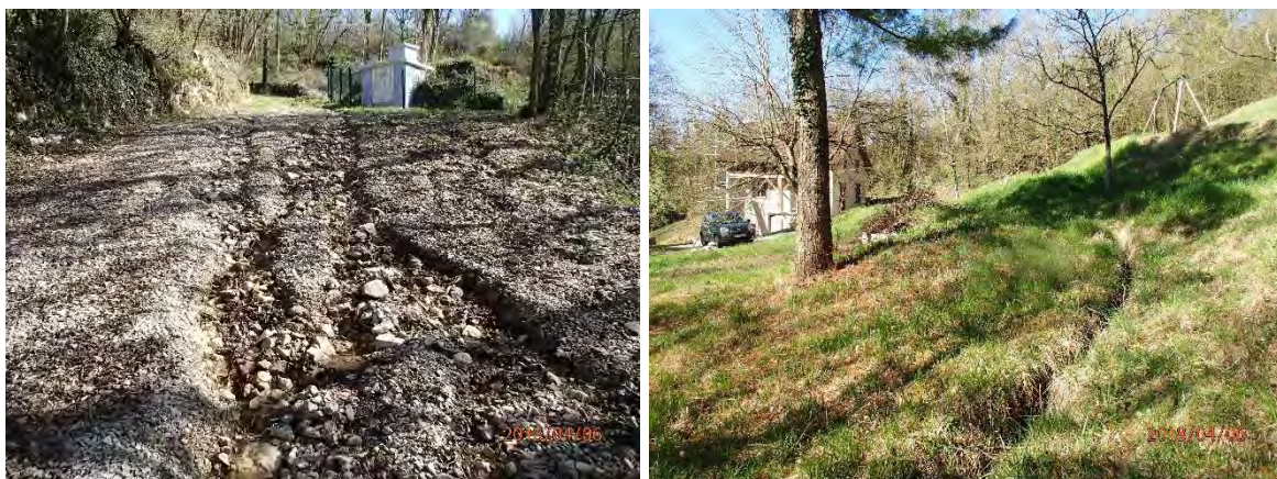
Figure 32 : Piste ravinée (à gauche) – terrasses et cunettes redirigeant les eaux vers l'Est, évitant ainsi la maison au second plan
