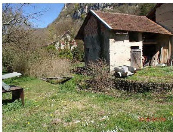
Figure 23 : Maisons à Petit Glandieu : au premier plan, une dépendance inondable – au second plan, une maison surélevée, au niveau de la route communale
