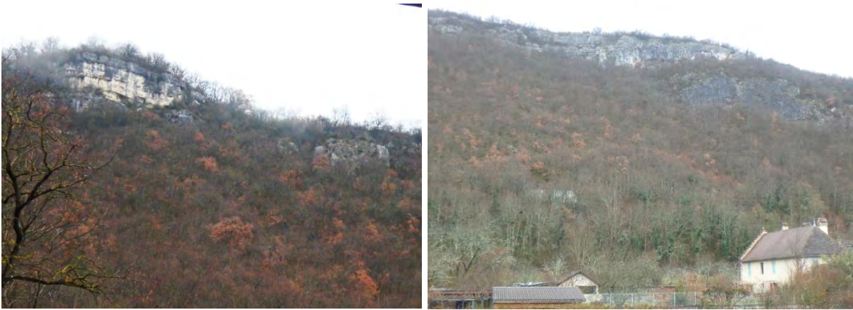
Figure 10 : Barre rocheuse de Perroset au droit de la partie Nord du chef-lieu
