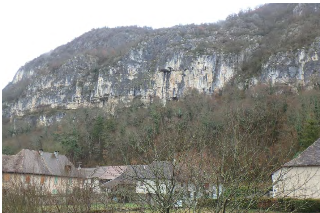
Figure 5 : vue d'ensemble de la falaise dominant Petit-Glandieu
