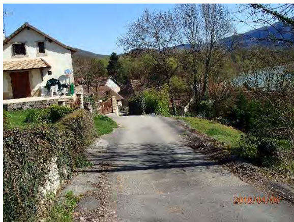
Figure 41 : Bourrelet de goudron permettant de guider la lame d'eau ruisselée
