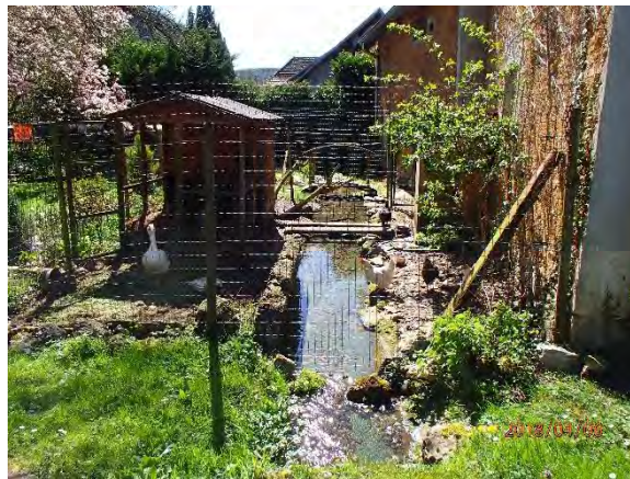
Figure 38 : Axe d'écoulement passant chez les particuliers
