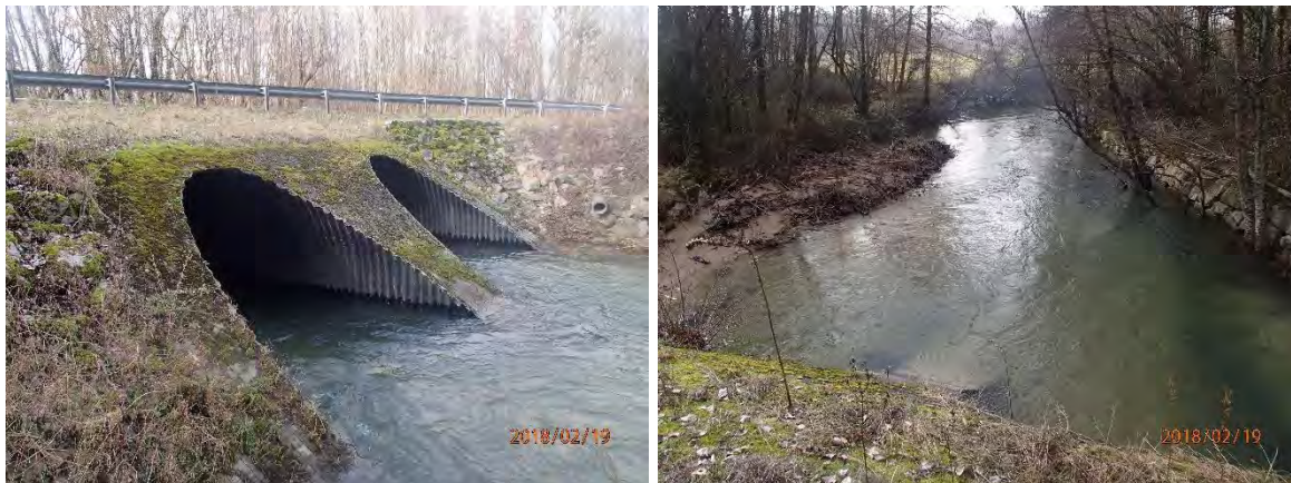
Figure 21 : Traversée de la RD19 et lit à l'aval
