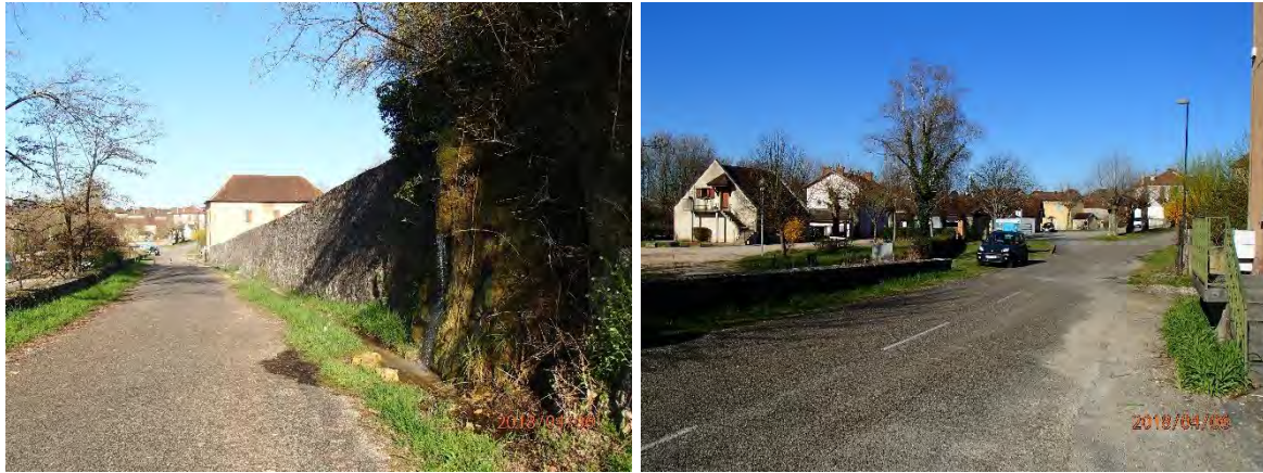
Figure 28 : Axe d'écoulement sur la route de Murs et Gélignieux
