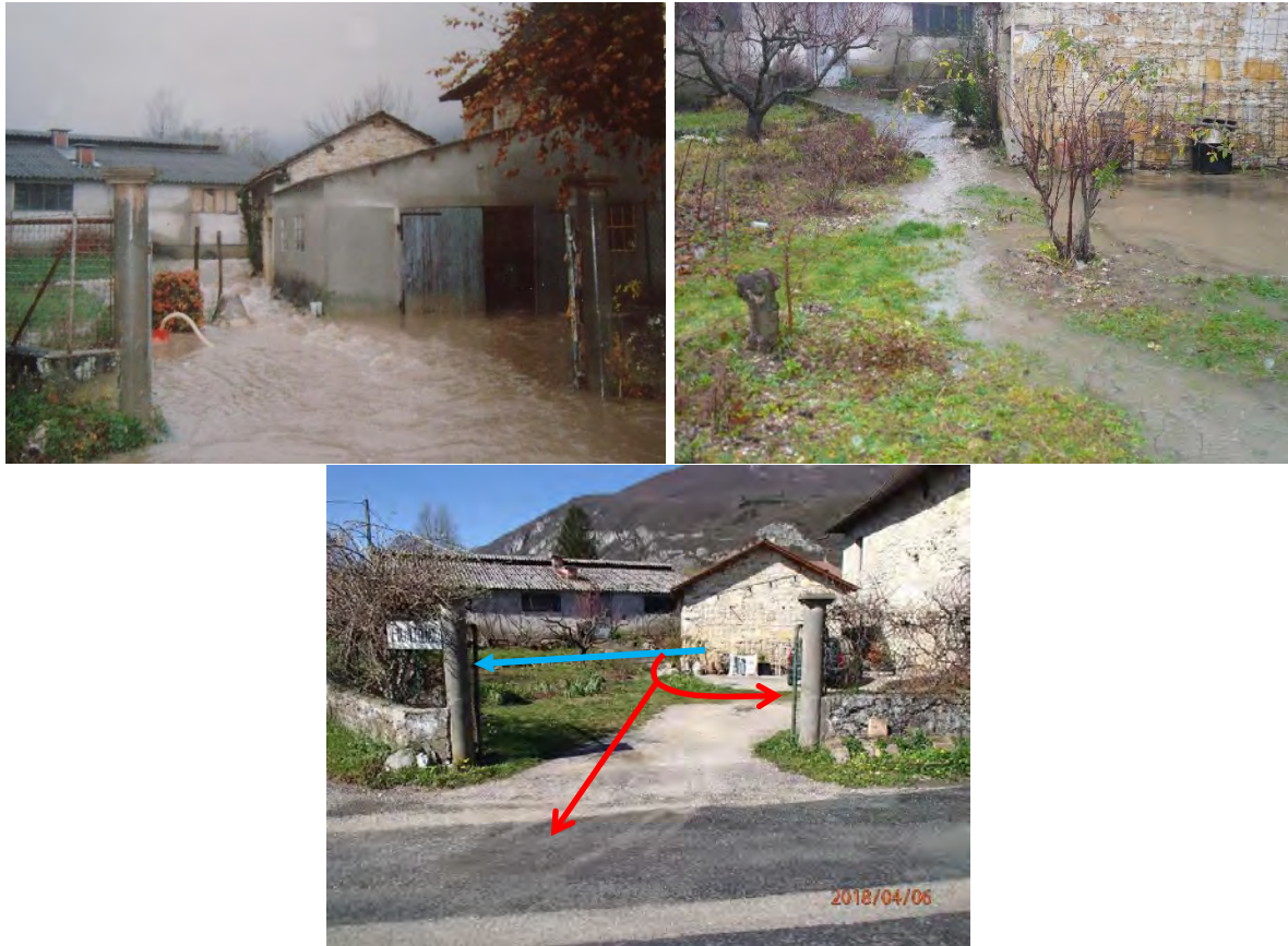
Figure 35 : Point de débordements : en 1990 (gauche), en 2018 (droite) et hors crue en bas
