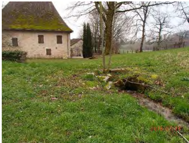
Figure 58 : Passage couvert sous une propriété, atteinte en cas d'obstruction de l'entrée de la buse
