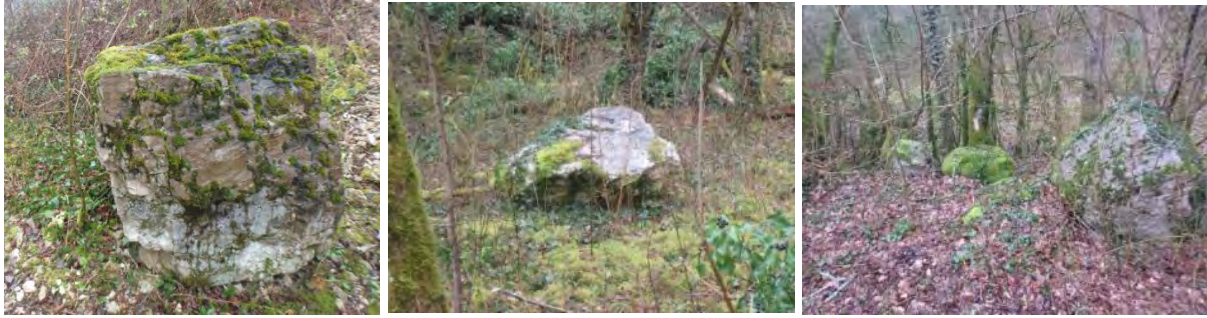
Figure 10 : exemple de blocs de l'ordre du mètre cube (ou +) éboulés visibles en pied de versant
