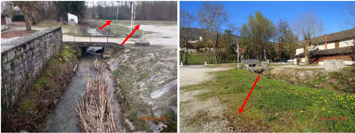
Figure 42 : Débordements préférentiels en rive droite à l'aval de la route départementale
