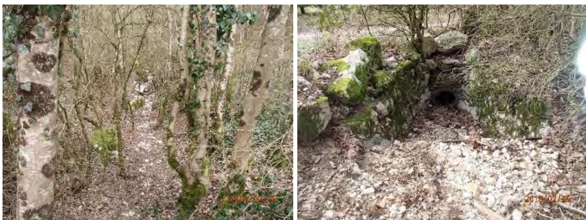
Figure 74 : Combe captée dans une buse
