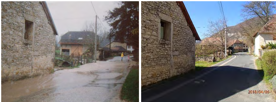
Figure 36 : Débordements en 1990 (à gauche) – comparaison à l'état actuel
