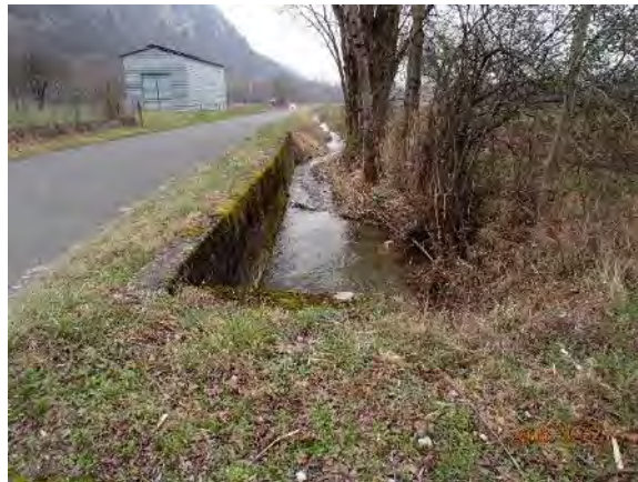
Figure 71 : Ruisseau à l'aval du bâtiment
