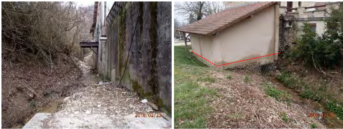
Figure 61 : Lit en amont et lavoir communal inondé à hauteur du trait en janvier 2018
