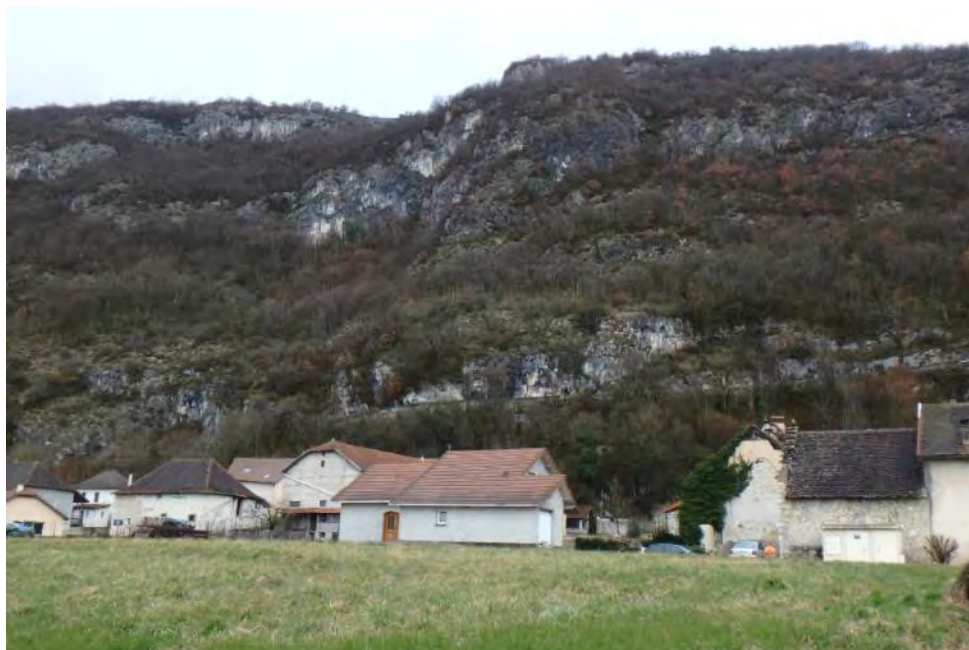
Figure 12 : versant rocheux au droit de Glandieu
