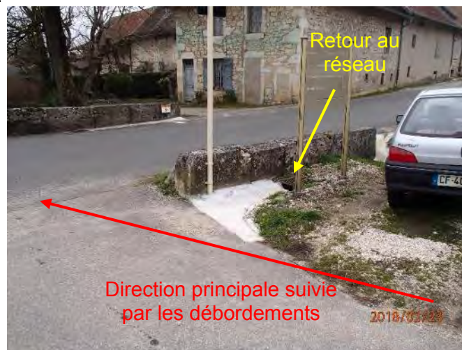
Figure 62 : Axe des débordements sur la voirie
