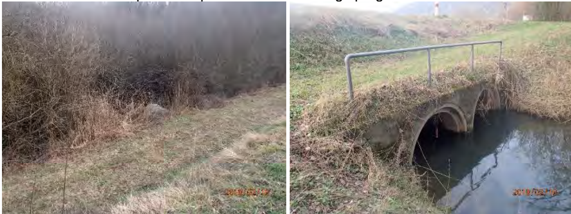
Figure 50 : Exemple de connections entre casiers d'inondation délimités par des routes dans la plaine
