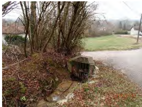
Figure 66 : Ouvrage grille en amont des enjeux
