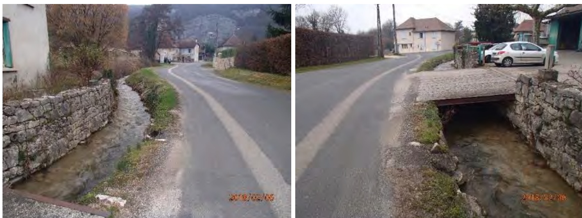
Figure 32 : Ruisseau de la Gorge longeant la route RD 10b sur la partie aval de La Burlanchère (vue vers l'amont à gauche, vers l'aval à droite)
