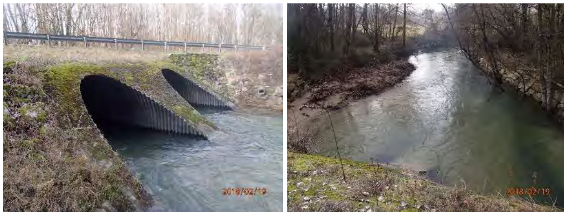
Figure 48 : Traversée de la RD19 et lit à l'aval
