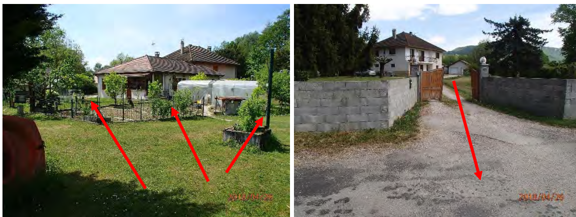
Figure 41 : Propriété exposée aux crues de la Gorge après déversement de l'étang
