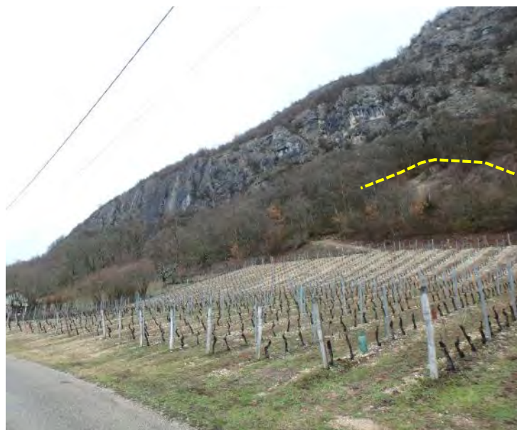
Figure 27 : zone instable en amont des Bonards
