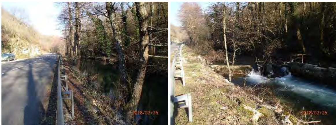
Figure 44 : Ruisseau du Gland le long de la RD10, en amont de la cascade
