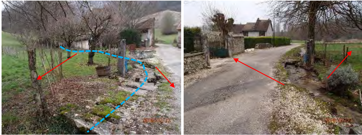
Figure 59 : Débordement probable sur la traversée de Varepe (en rouge) du cours d'eau (axe du cours d'eau en bleu) – Vue vers l'amont à gauche, vers l'aval à droite
