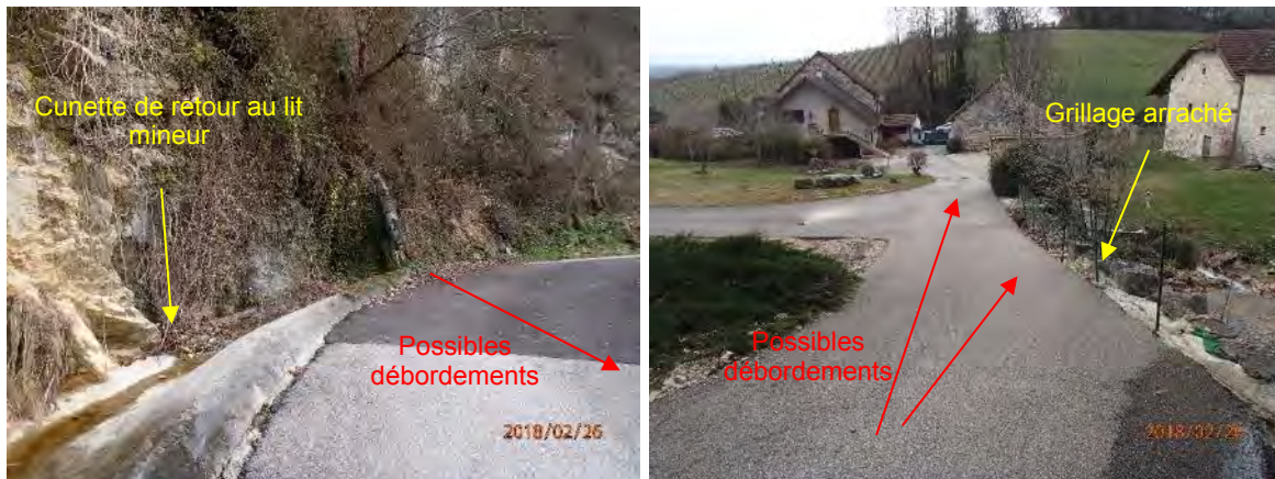
Figure 68 : Axe des débordements en cas de divagation en amont de la cascade
