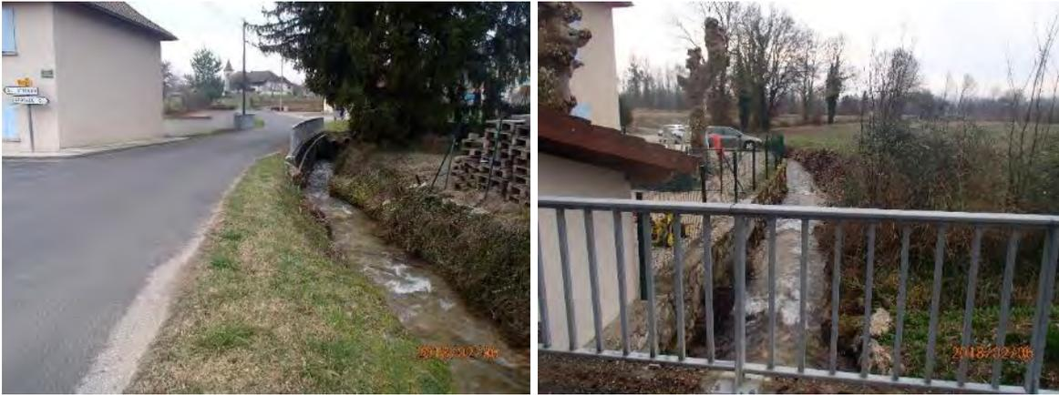
Figure 24 : Coude à 90° sous la route au carrefour RD10b/ RD10c et lit à l'aval
