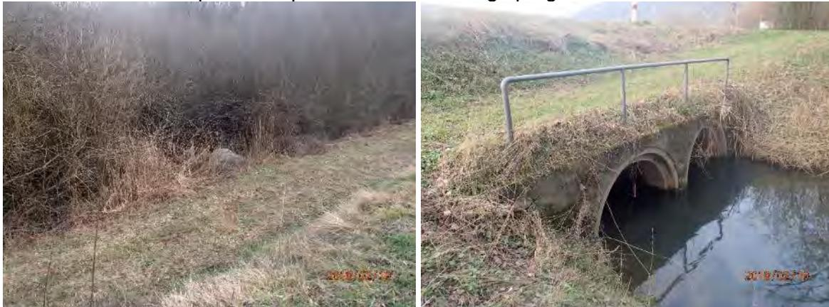
Figure 40 : Exemple de connections entre casiers d'inondation délimités par des routes dans la plaine
