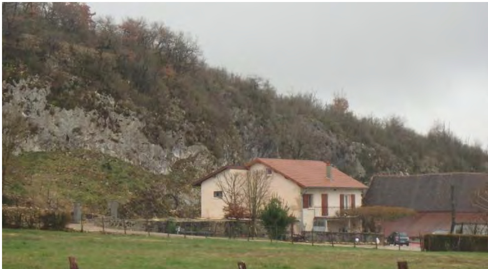
Figure 6 : paroi rocheuse au droit des habitations de la Plaine
