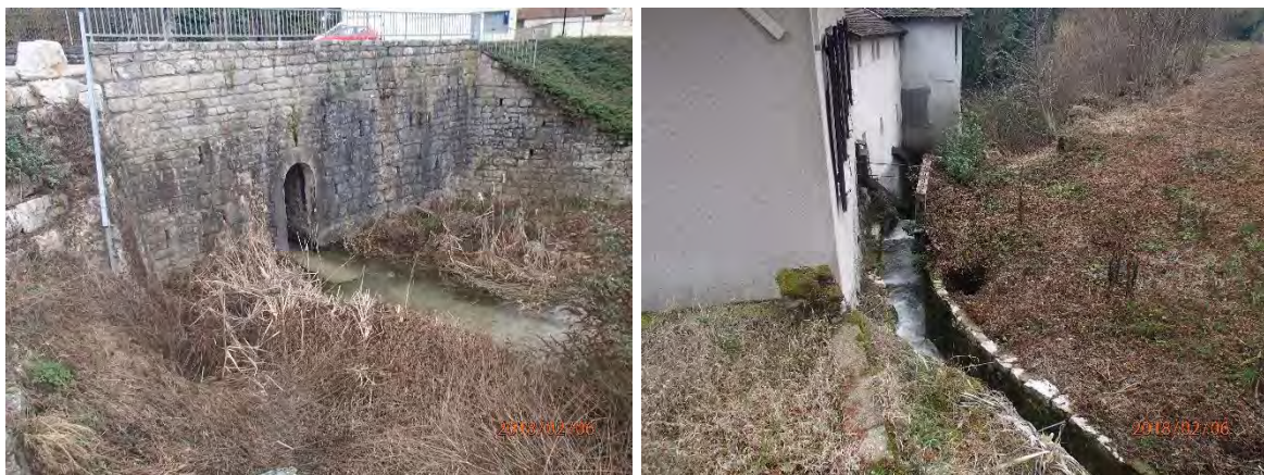
Figure 41 : Rejet dans l'écluse et lit en aval de la troisième route communale
