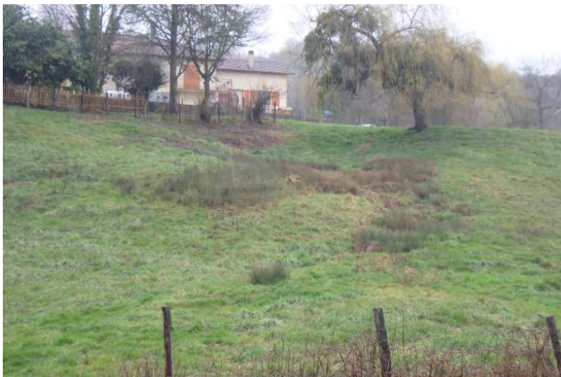
Figure 14 : terrain instable entre Rix et la RD19
