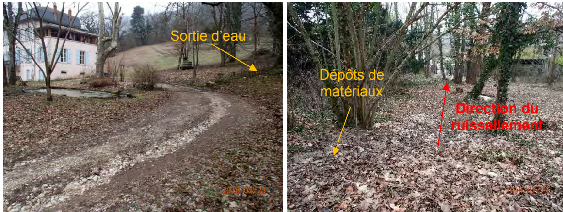
Figure 59 : Sortie d'eau et traces de ravinement sur la piste (à gauche) - écoulement possible vers la voie publique (à droite)
