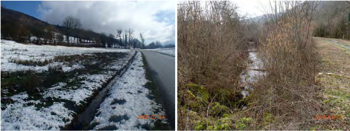
Figure 50 : Accumulation des eaux de ruissellements le long la RD 79 (à gauche) - Accumulation des eaux en contrebas de la route RD 19 (à droite)
