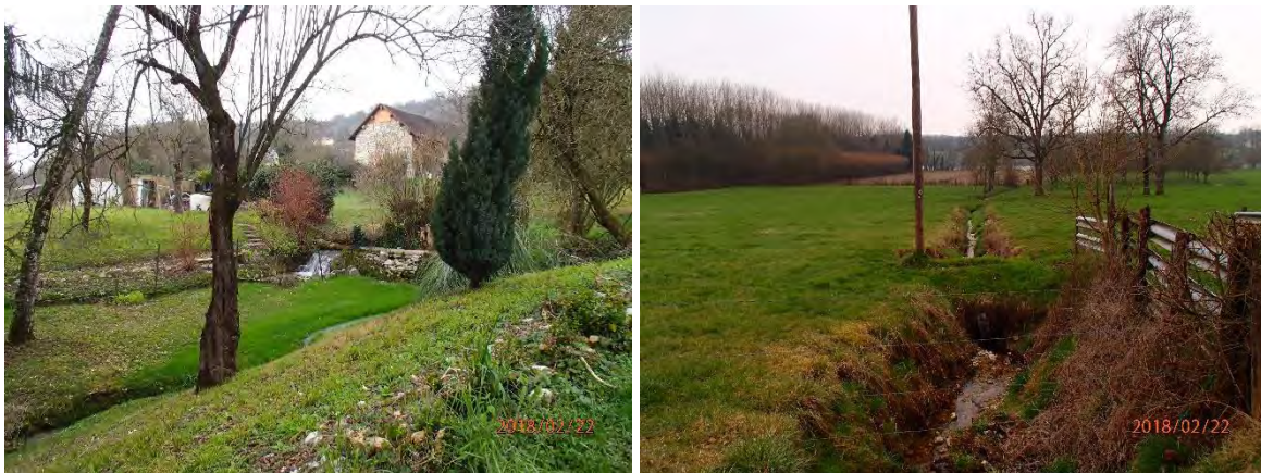
Figure 53 : Lit encaissé à proximité des enjeux (à gauche) - lit à l'aval de la RD 19 (à droite)
