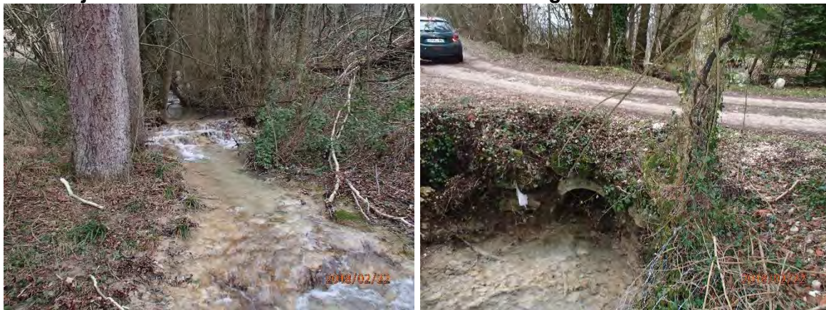
Figure 26 : Franchissement du ruisseau issu du Creux du Nant à Saint Martin
