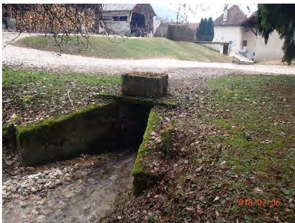
Figure 38 : Franchissement sous une propriété avec court passage à ciel ouvert
