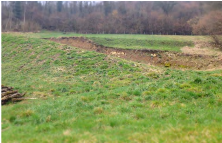
Figure 8 : terrassement permettant de voir un sol de mauvaise qualité
