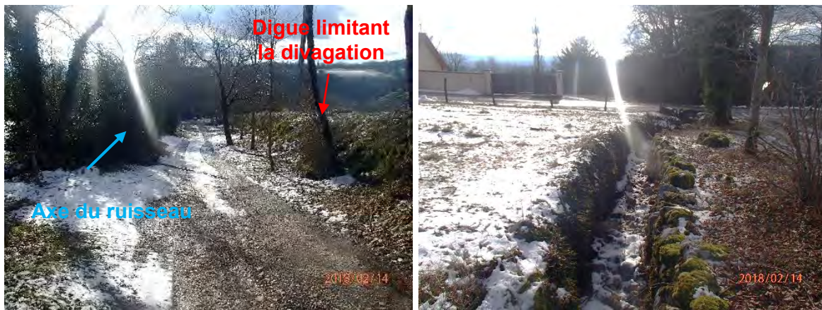
Figure 20 : Digue à droite d'une piste d'accès à une propriété (à gauche) – canal empierré à l'approche de la route communale (à droite)
