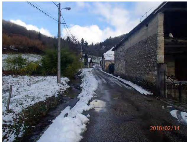
Figure 18 : Lit à capacité hydraulique très réduite
