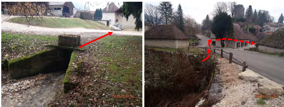
Figure 44 : Direction suivie par les débordements après obstruction des ouvrages
