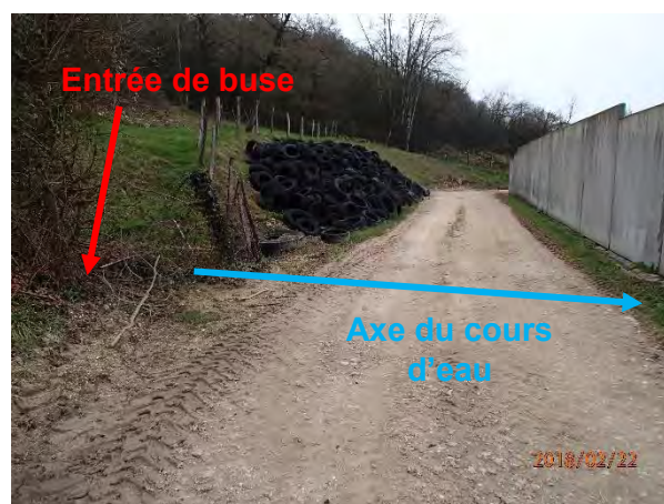
Figure 54 : Face amont des bâtiments agricoles
