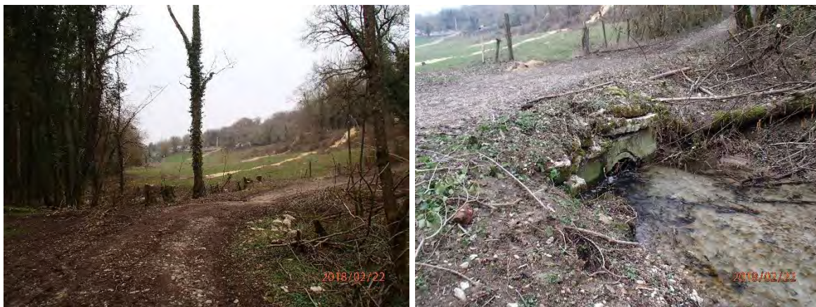
Figure 46 : Franchissement d'une piste sur le ruisseau du Moulin vers la cote 355
