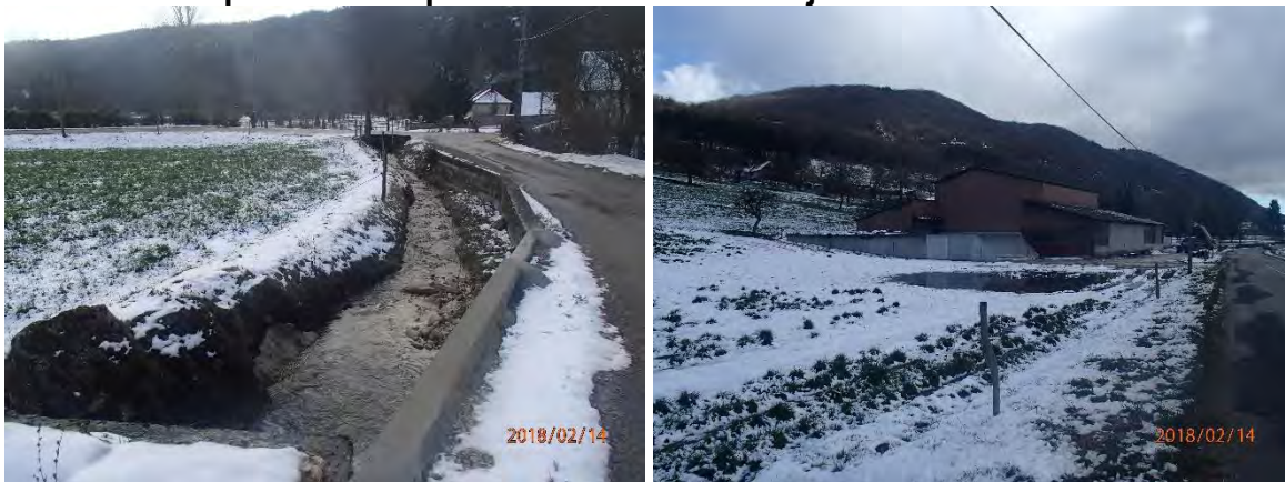
Figure 19 : Aménagement du ruisseau en amont de la RD et accumulation d'eau en rive gauche
