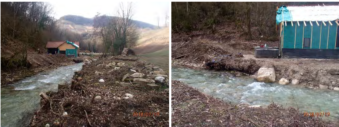
Figure 13 : Propriété en cours de construction exposée aux crues de la Brive
