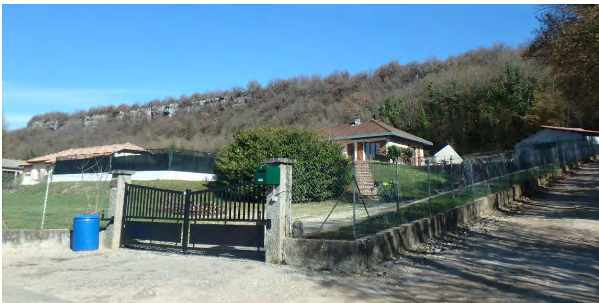
Figure 3 : vue d'ensemble de la falaise dominant Dormieu
