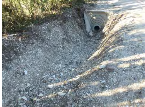
Figure 22 : aménagement collecteur de ruissellement
