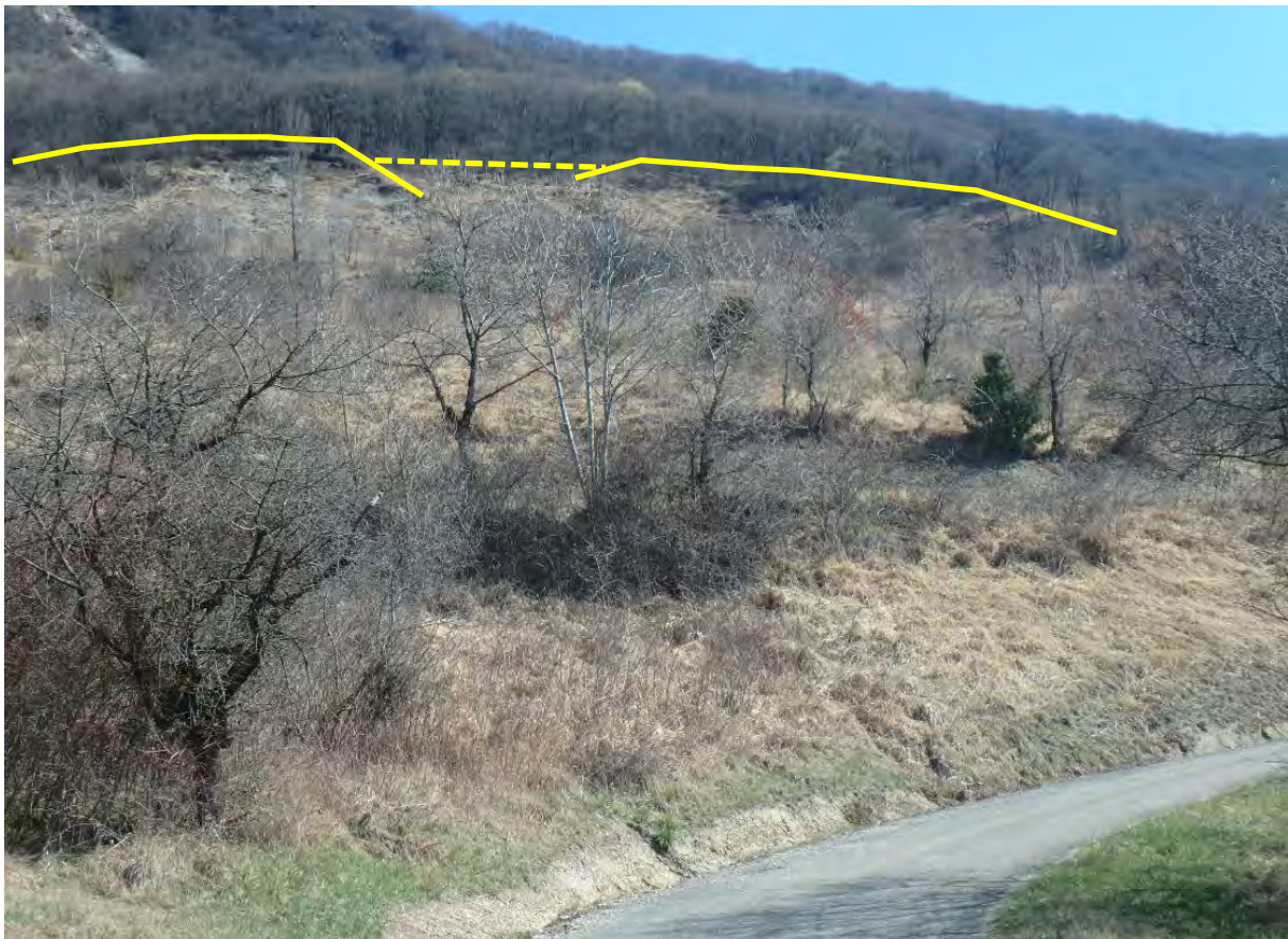
Figure 8 : Zone en glissement actif en amont de la route de Seyssel
