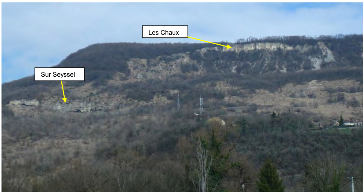
Figure 5 : falaises des Chaux et de Sur Seyssel
