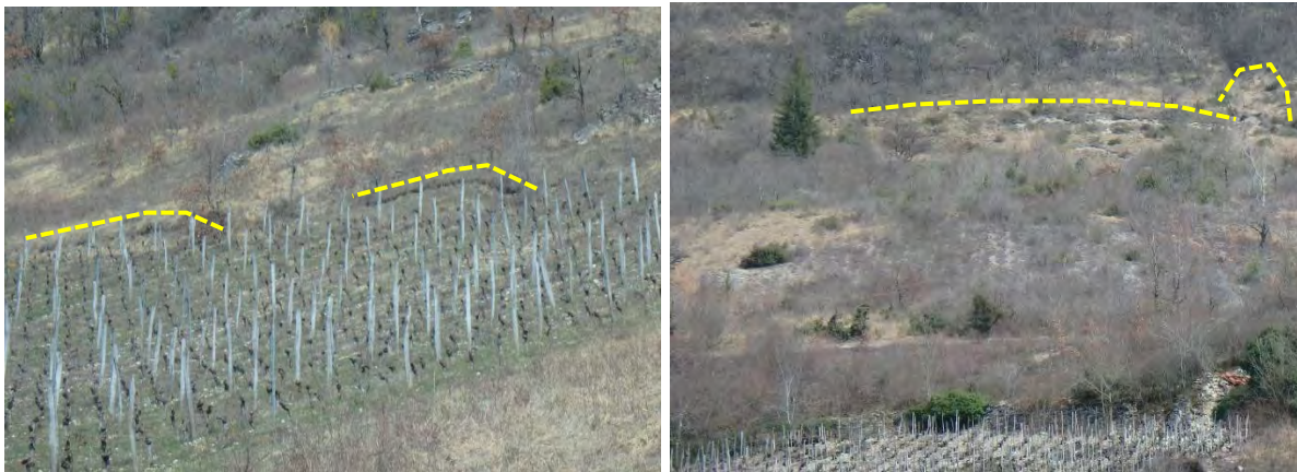
Figure 9 : Décrochements visibles sur le versant
