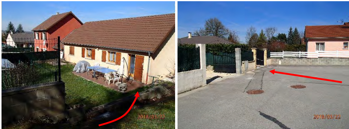
Figure 37 : Direction des débordements et exemple de propriétés exposées
