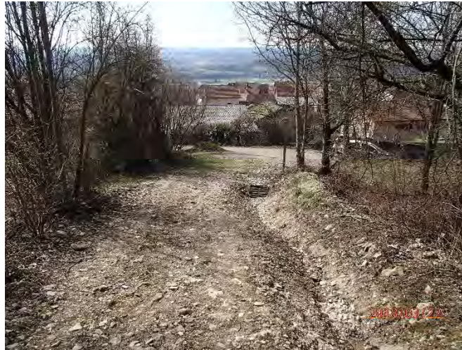
Figure 20 : Risque d'obstruction d'une grille en amont immédiat du chef-lieu
