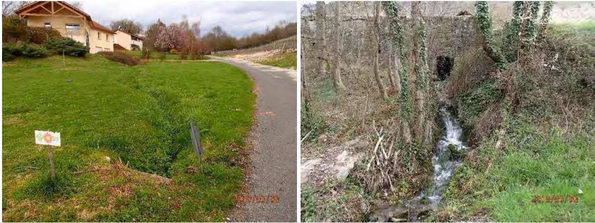
Figure 23: Axe en amont du busage (à gauche) - Axe à nouveau à ciel ouvert à l'aval du lavoir
