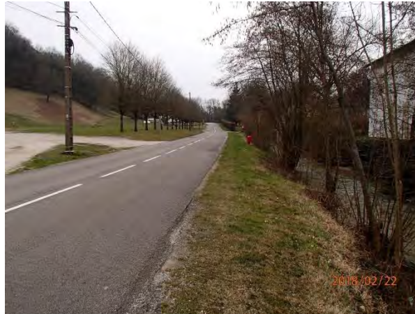
Figure 14 : Partie amont de la traversée
