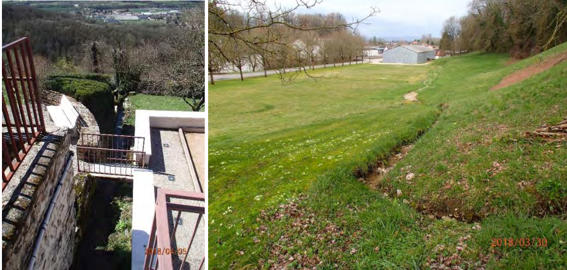
Figure 30 : Axe de ruissellement issu du chef-lieu (à gauche) et débouchant en bordure de la Brive au hameau des Granges (à droite)
