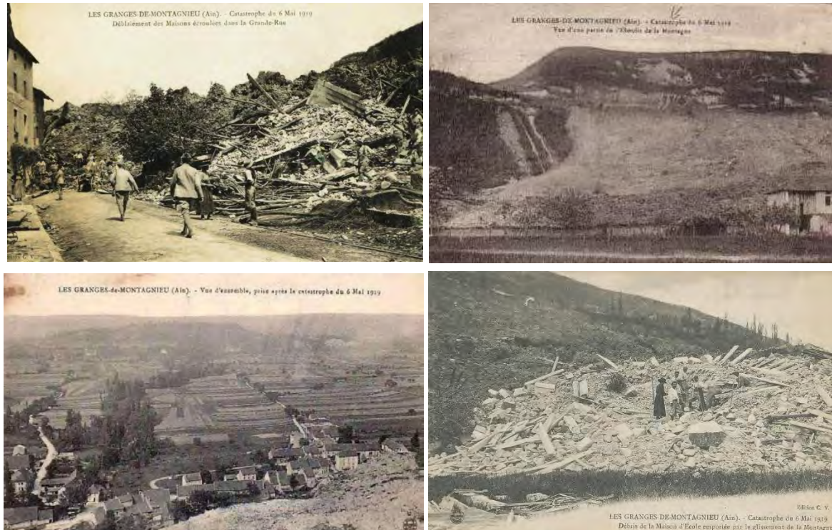
Figure 6 : clichés du glissement de 1919 (cartes postales anciennes, source : web)
