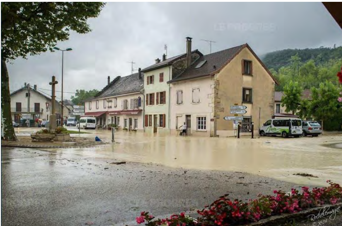
Figure 43 : cliché de l'inondation de juillet 2014 (source : Le Progrès)
