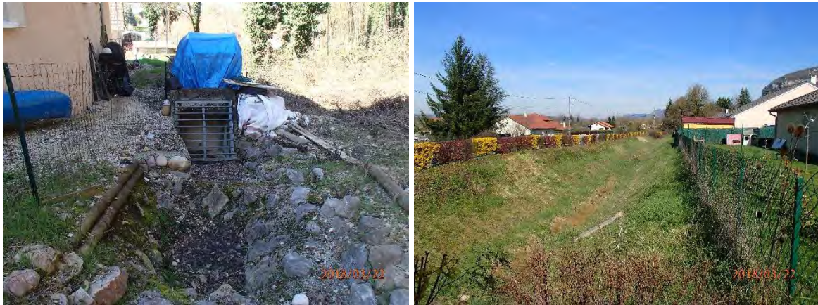
Figure 34 : Axe de déviation busé de derrière une propriété du lotissement jusqu'à un fossé en bord de route départementale
