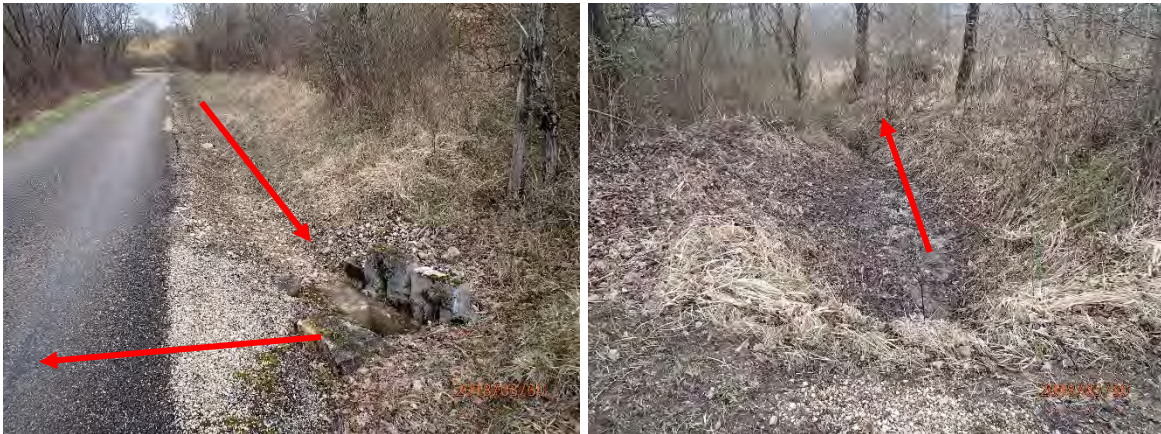
Figure 32 : Cunette et exemple de rejet dans sur le versant alimentant la ravine
