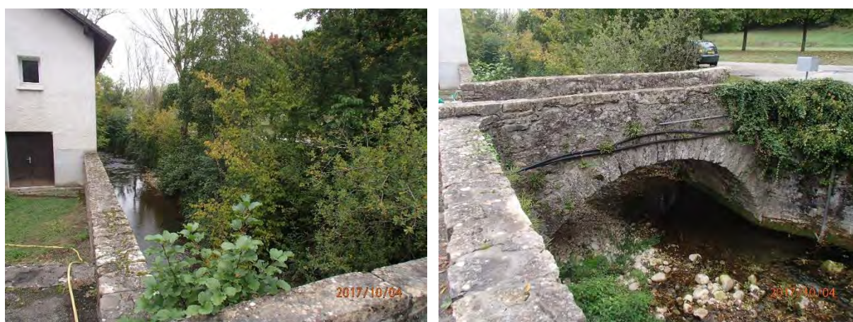
Figure 13 : premier ouvrage de franchissement dans la traversée du hameau des Granges
