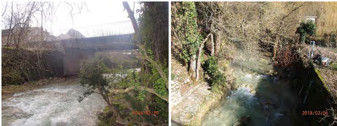
Figure 20 : Pont amont et lit en amont
