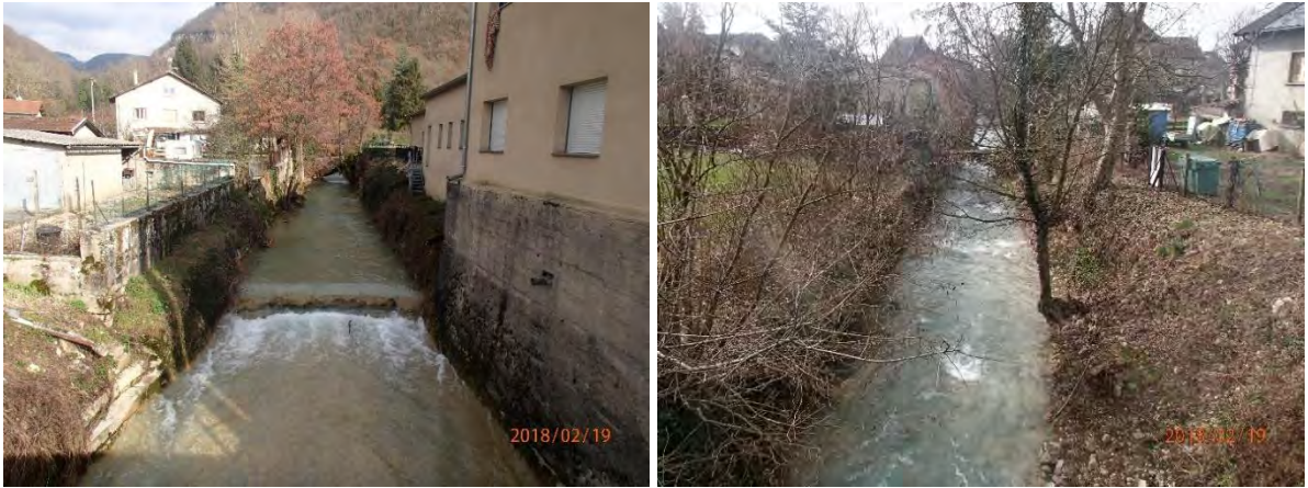
Figure 16 : Lit chenalisé entre les deux ponts : vue depuis le pont de la RD vers l'amont à gauche, vue depuis le pont communal vers l'aval à droite
