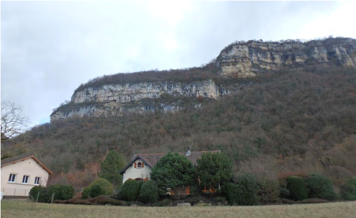
Figure 3 : vue d'ensemble des deux zones de la falaise de Seyssel
