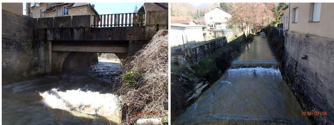
Figure 27 : Pont aval et lit en amont
