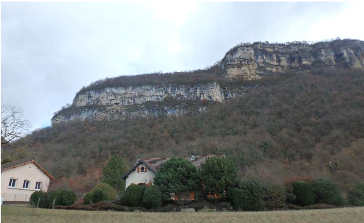
Figure 4 : vue d'ensemble des deux zones de la falaise de Seyssel
