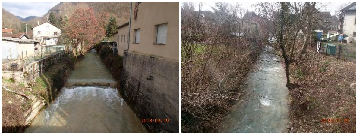
Figure 22 : Lit chenalisé entre les deux ponts : vue depuis le pont de la RD vers l'amont à gauche, vue depuis le pont communal vers l'aval à droite
