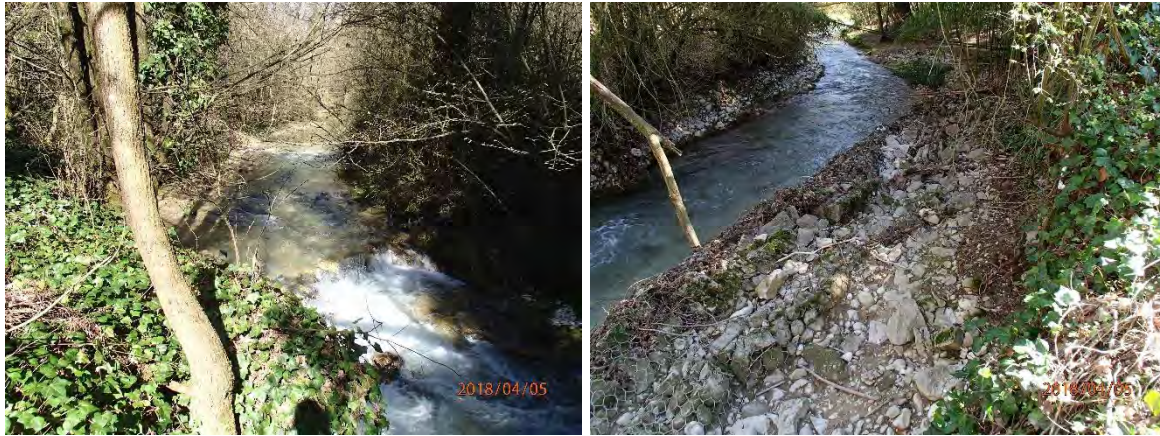
Figure 28 : Seuil fixant le lit (à gauche) - gabions basculés (à droite)
