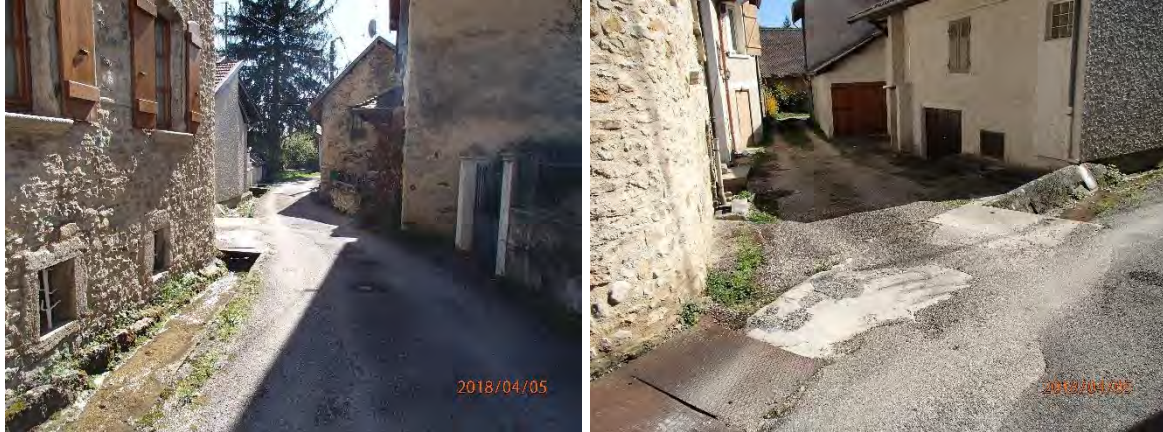
Figure 38 : Canal et cours en point bas pouvant être inondée en cas de débordements
