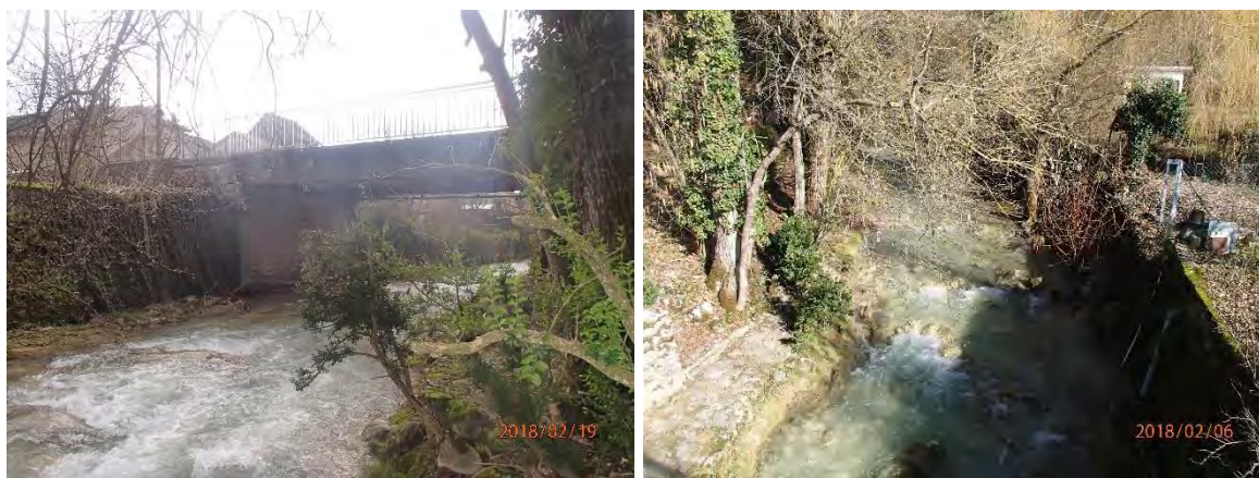
Figure 26 : Pont amont et lit en amont
