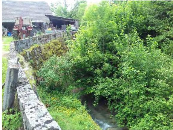
Sur ce tronçon, le ruisseau est franchi par un pont. Comme en amont, son gabarit est réduit mais l'ouvrage peut être mis en charge sur plusieurs mètres. En revanche, au vu de la dégradation du parement amont du pont, la stabilité de la route en cas de mise en charge est incertaine. Les débordements rejoindraient directement le lit aval.
