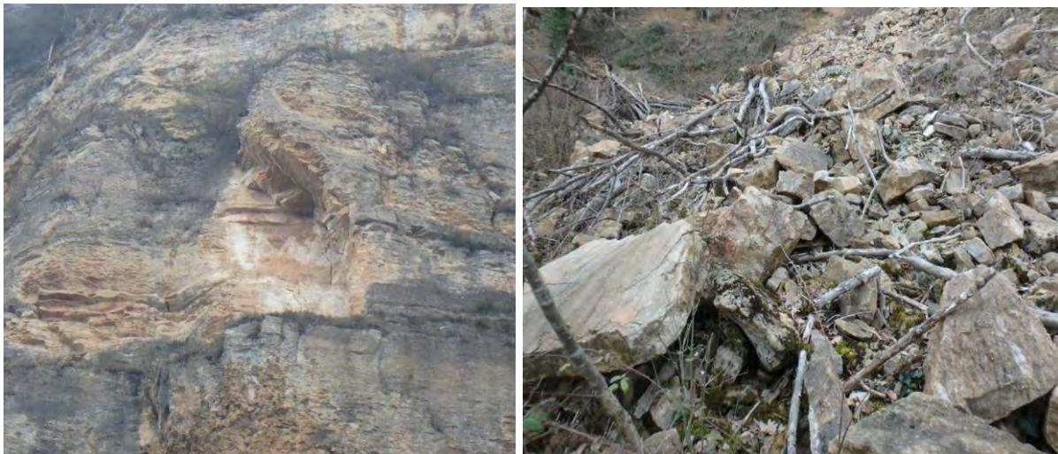
Figure 9 : cicatrice déboulement constaté et matériaux éboulés
