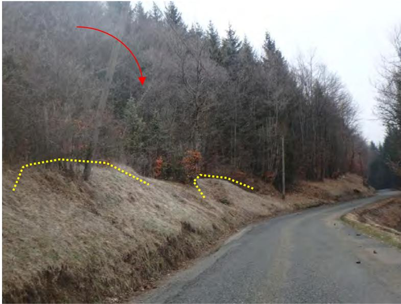
Figure 19 : Talus routier bombé et poteau incliné au droit de la RD99
