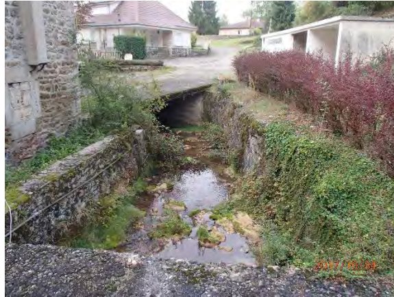
Figure 18 : Ouvrages sur le Rhéby au niveau des premiers enjeux
