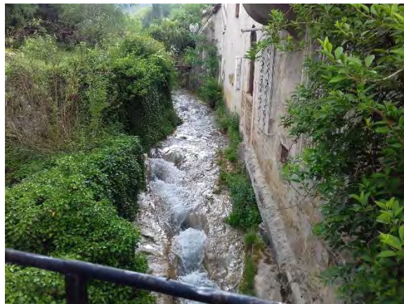
Figure 26 : Propriété rive gauche en amont de la passerelle menant au lavoir des Sœurs.
