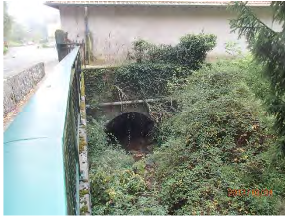
Figure 22 : Passage couvert sous l'école
