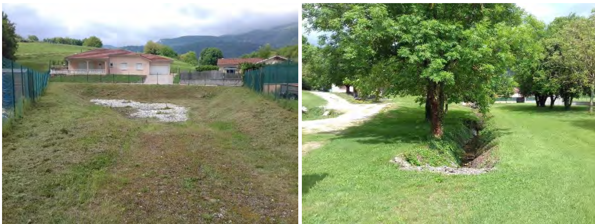
Figure 40 : Bassin d'orage et chenal à ciel ouvert
