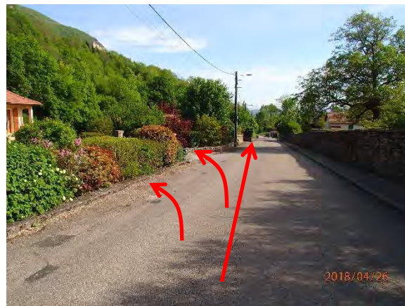
Figure 36 : Déversement vers les propriétés en rive gauche et débordements sur voirie
