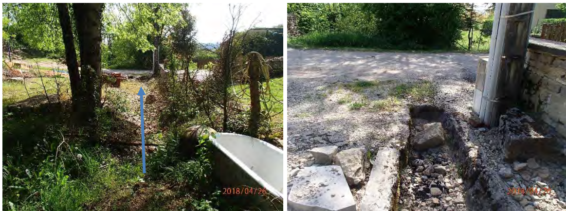
Figure 32 : Débouché du Riou en amont du chemin piétonnier
