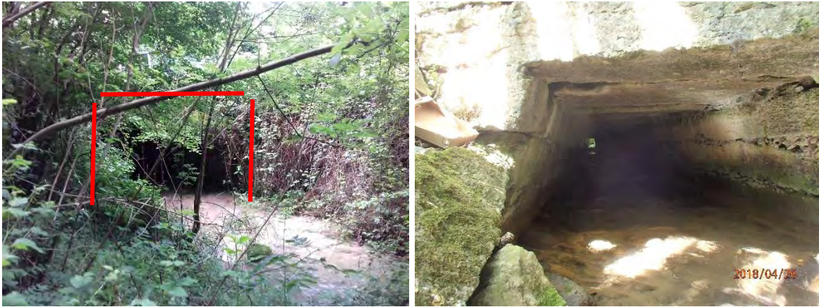
Figure 20 : Deux passages couverts sur le linéaire encaissé
