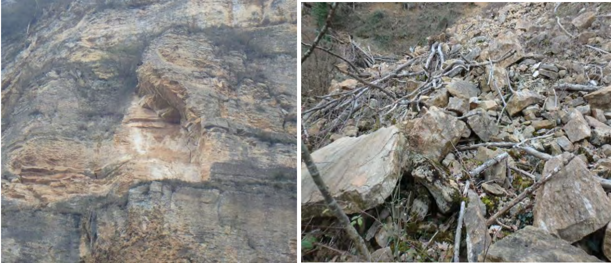
Figure 8 : cicatrice déboulement constaté et matériaux éboulés
