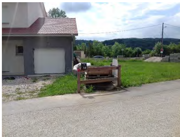
Figure 41 : Regard sur la partie enterrée
