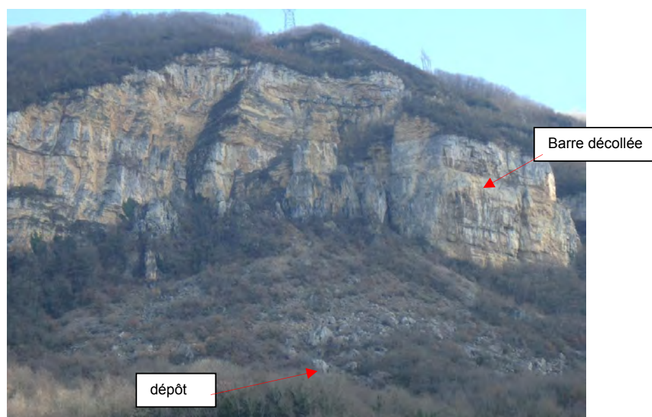
Figure 4 : vue de la zone éboulée sur le secteur d'en Chanot
