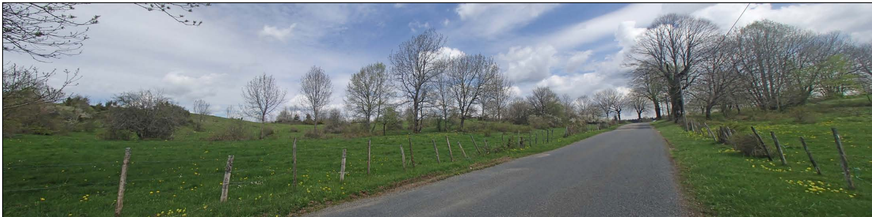
VUE N°3 : Vue depuis la route départementale n°34, en direction de l'Est. La voirie est ici à niveau des champs latéraux et pourrait recevoir un accès. Noter la faible largeur de chaussée qui témoigne d'une infrastructure secondaire, peu propice à recevoir un fort trafic.
