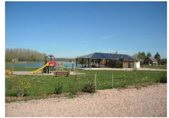
Guinguette - toiture photovoltaïque
