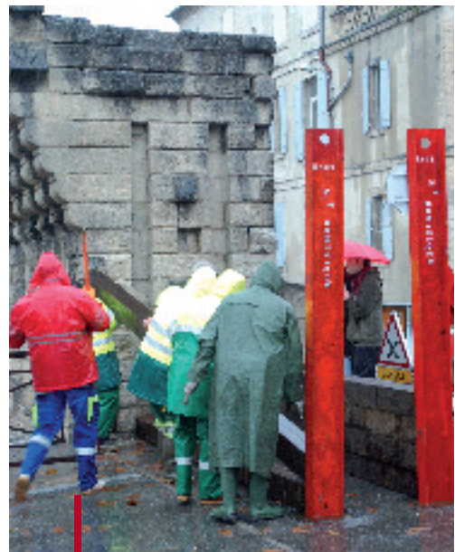
Test de mise en place de batardeaux
