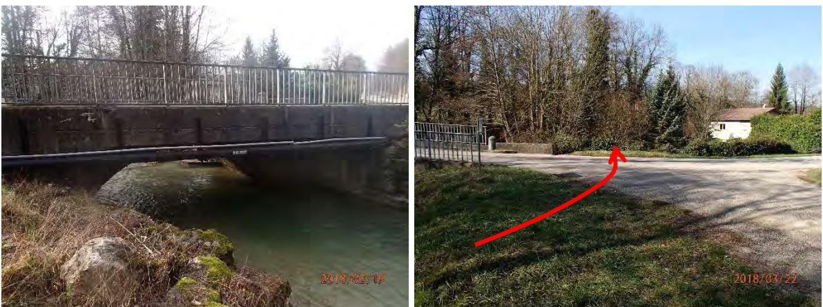
Figure 19 : Débordements au droit du pont de la RD79 en cas d'obstruction par embâcles
