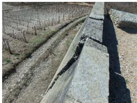
Figure 10 : à gauche, arrachement d'un glissement ancien, à droite mur de soutènement fissuré
