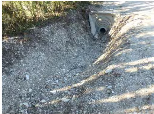
Figure 27 : aménagement collecteur de ruissellement
