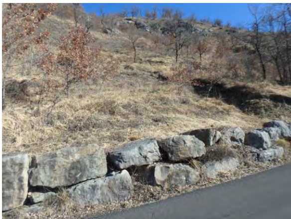
Figure 10 : à gauche, arrachement d'un glissement ancien, à droite mur de soutènement fissuré
