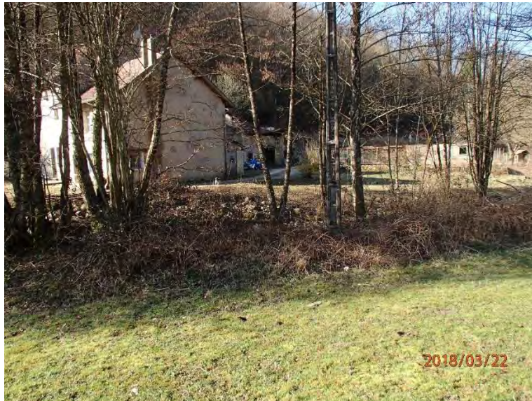
Figure 16 : Propriété exposée sur le secteur de l'ancien moulin
