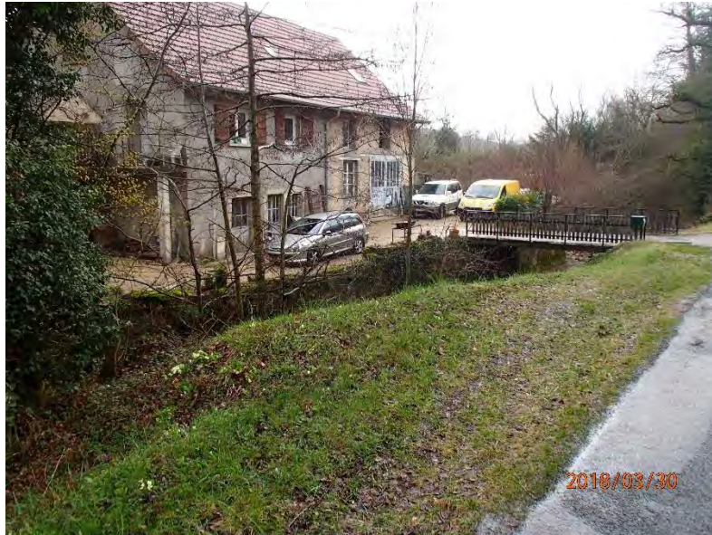
Figure 20 : Propriété exposée aux crues de la Brive
