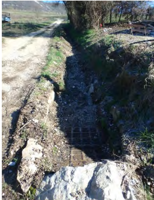
Figure 25 : fossé collectant des ruissellements des coteaux avec grille obstruable
